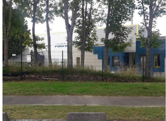
Photo 8 : Société PERIMECA (rue Diderot)
