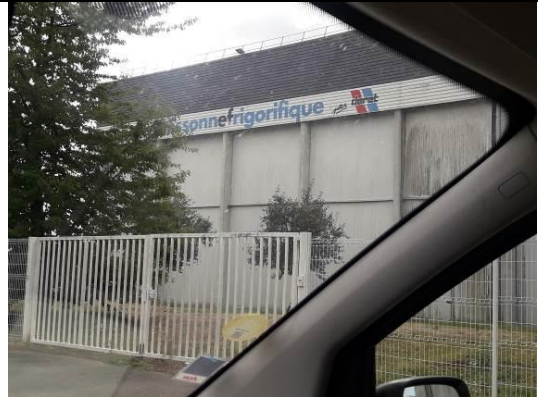
Photo 2 : Esbonne frigorifique (rue de l'abbé Grégoire)
